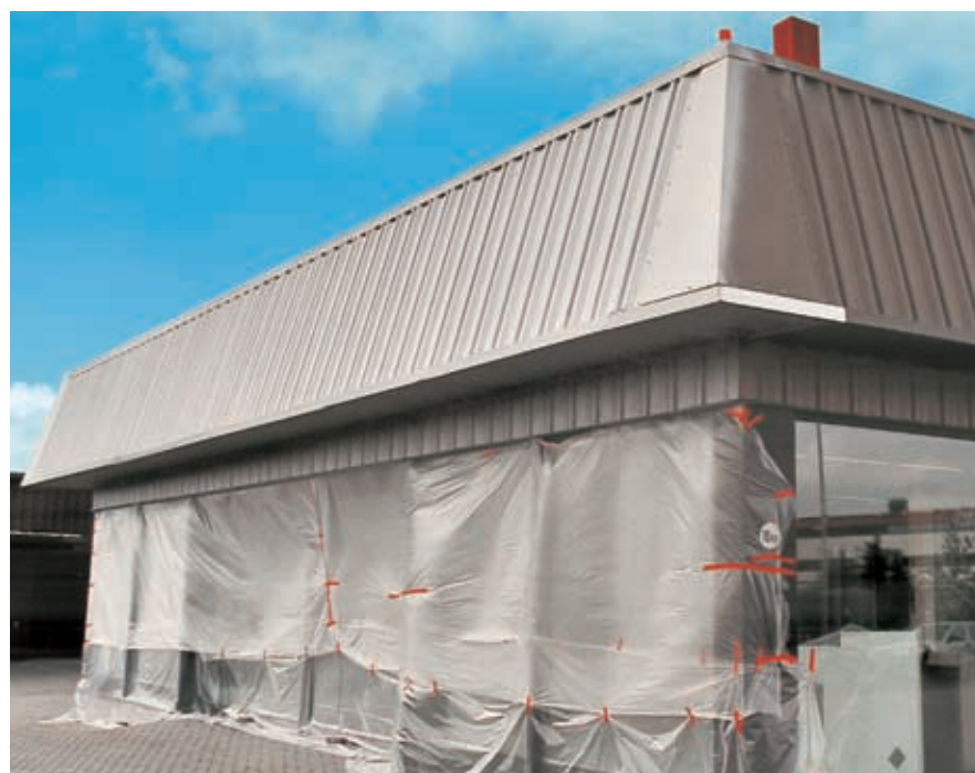
Abb. 7: Überlackierung einer Altfassade
