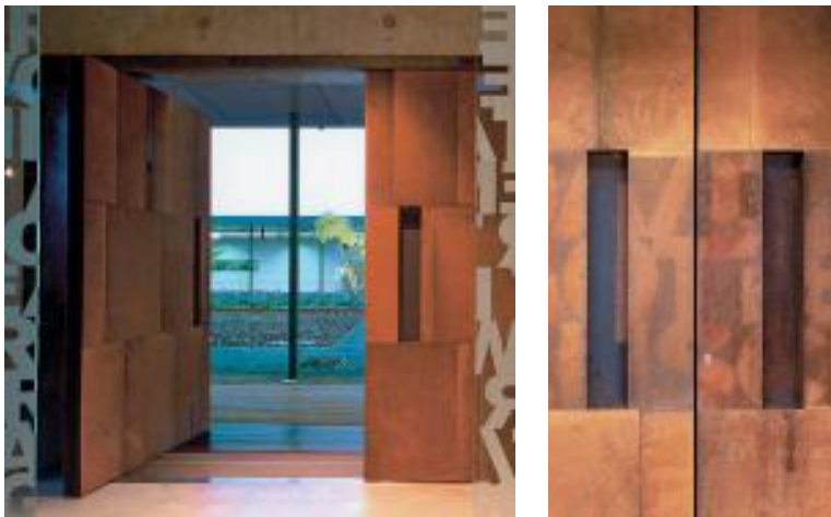
Abb. 30: Zweiflügelige Eingangstür der Kirche: Ansicht von innen und Detail von außen im Bereich der Tür(ein)griffe
