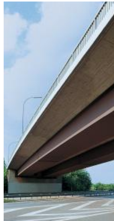
Abb. 43: Rüschelbrücke, Endfeld über der Brackeler Straße, Dortmund
