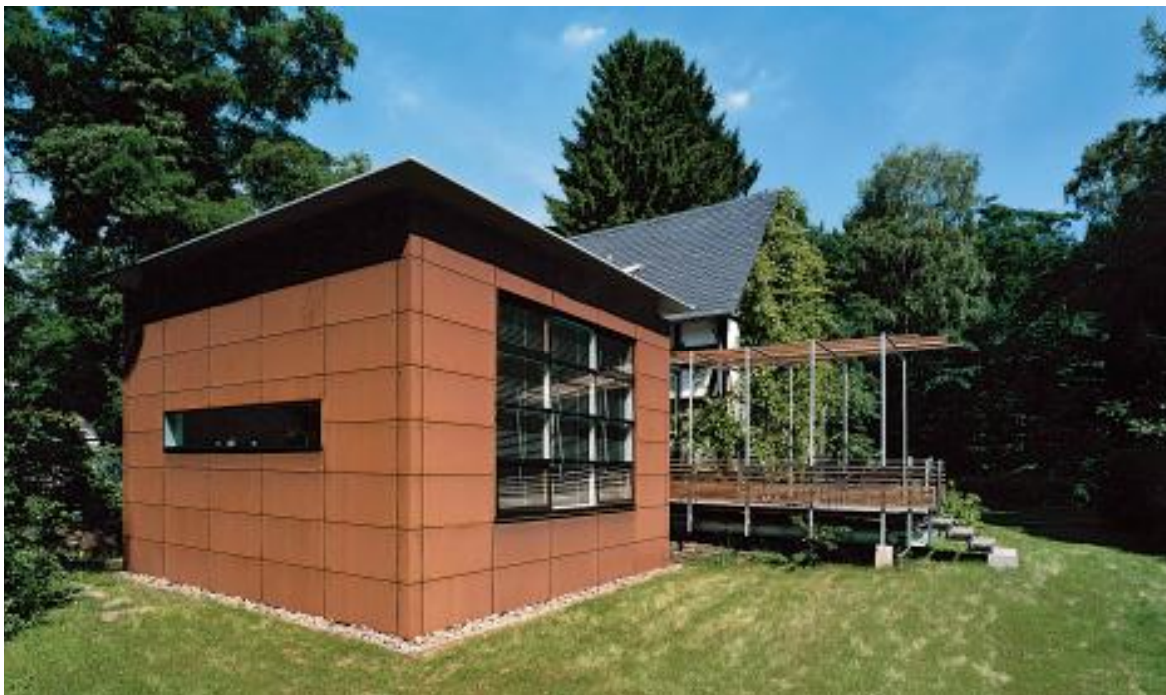
Abb. 23: Fachwerkhausanbau mit Fassadenplatten aus Wetterfestem Stahl
