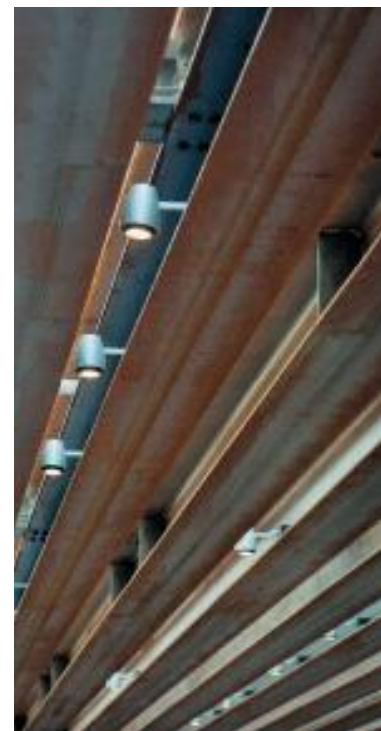
Abb. 19: Sichtbare, vollwandige Dachträger im Innenraum
