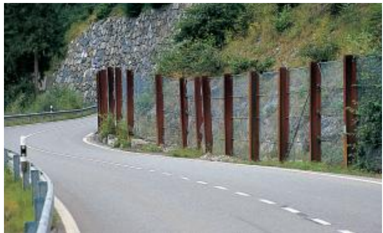
Abb. 47: Ständer einer Geröll- und Schnee-Schutzverbauung in der Schweiz
