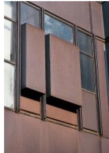
Abb. 4: Die Flächen, die direkt unter den beiden hervorstehenden Fassadenelementen liegen, weisen eine hellere Braunfärbung auf. Sie sind weitgehend nur indirekt benetzt.
