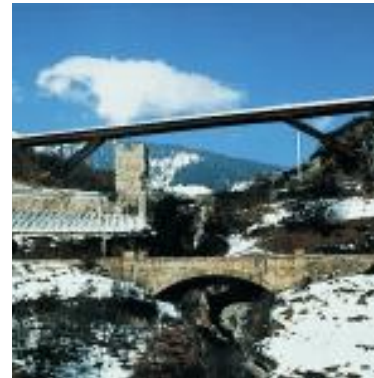
Abb. 36: Dalabrücke, Rahmenbrücke mit geneigten Stielen
