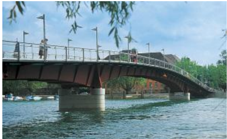
Abb. 38: Fußgänger- und Radfahrerbrücke über den Seerhein in Konstanz
