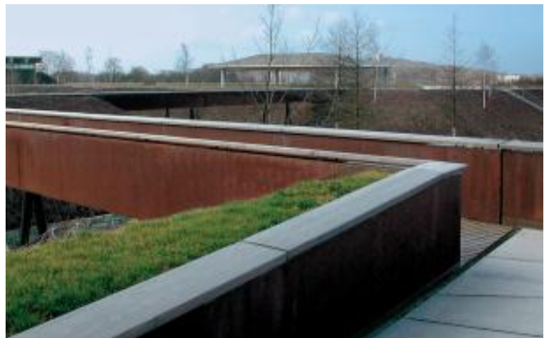
Abb. 33: Übergang von der in den Wall eingeschnittenen Rampe zur Brücke
