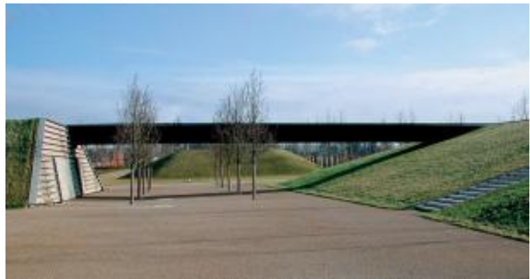
Abb. 32: Fußgängerbrücke am Kiosk, Potsdam
