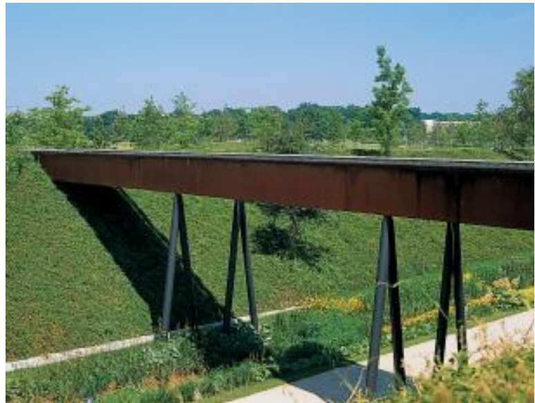
Abb. 31: Brücke mit Zwischenstützen
