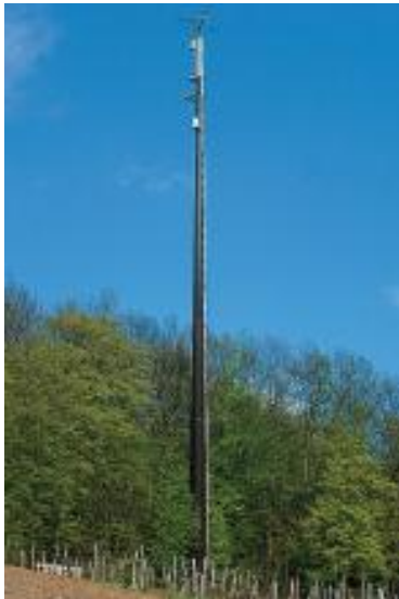
Abb. 44: Fernsehumsender. Etwa 100 Exemplare wurden von der Post um 1980 gebaut. Höhe zwischen 60 und 70 m, Blechdicke des Rohrquerschnitts 10 bis 15 mm.
